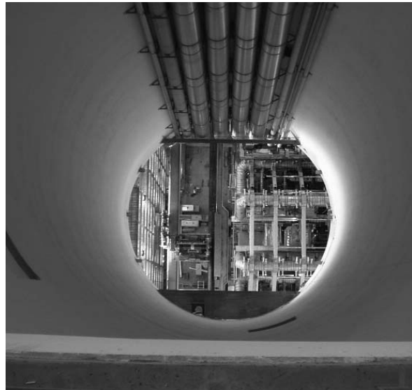
OP EEN DIEPTE VAN BIJNA 100 METER ZIJN ZE AAN HET WERK, DE MONTAGE VAN DE ATLAS DETECTOR
