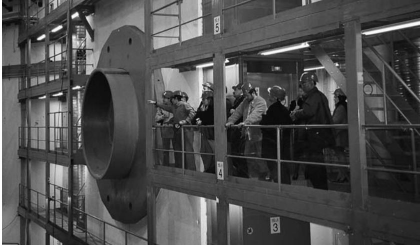
WE STAAN HIER OP HET NIVEAU VAN DE TUNNEL. LINKS ZIE JE HET BEGIN VAN DE TUNNELBUIS
