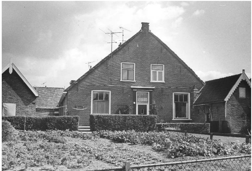
DE MONUMENTALE BOERDERIJ, DE KOPERSLAGER WERD GERED VAN DE SLOPERSHAMER MAAR GING DOOR BRAND EEN PAAR JAAR LATER ALSNOG VERLOREN.
