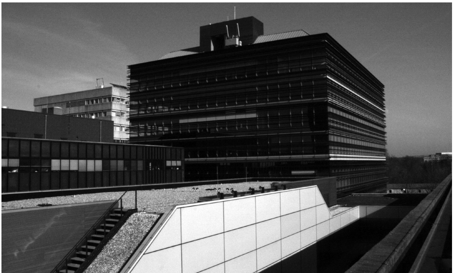
Het nieuw onderwijsgebouw nadert zijn voltooiing. Rechtsvoor zie je nog een stukje van het Minnaertgebouw. Het lichte gedeelte is 'de Loop', een gedeelte met hoor- en werkcollegeruimtes en daaronder de fietsenkelder. Linksachter zie je een deel van aardwetenschappen en de bovenste verdiepingen van het Wiskundegebouw.
